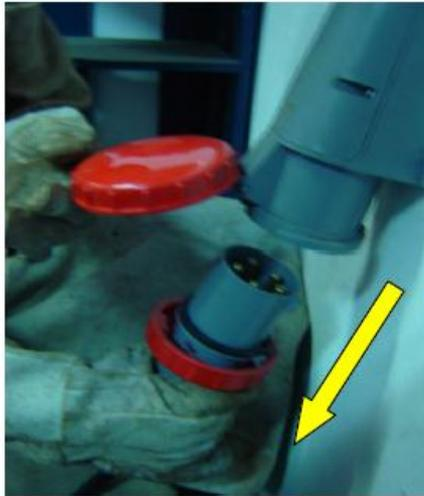
**Fig. 44** – Desconectando equipamento Da Rede Elétrica
