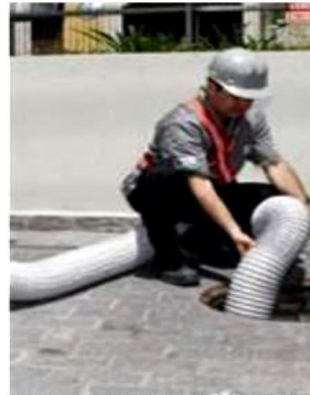
**Fig. 5** – Ventilação forçada.
